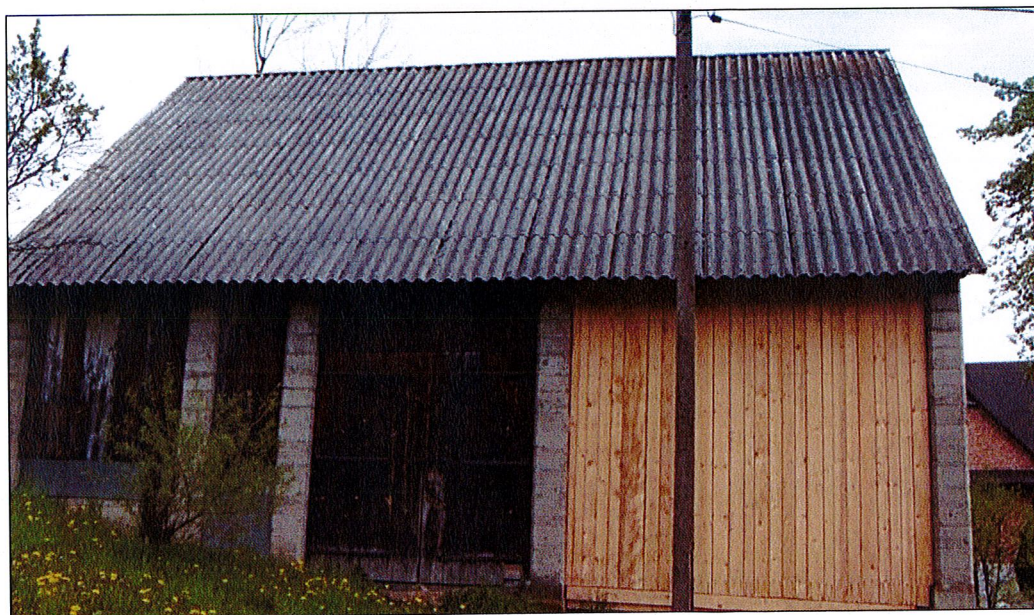
Rys. 6. Zdjęcie obrazujące wykorzystywanie wyrobów azbestowo-cementowych jako element pokrycia dachowego (eternit falisty), źródło: zdjęcie własne – inwentaryzacja w terenie
